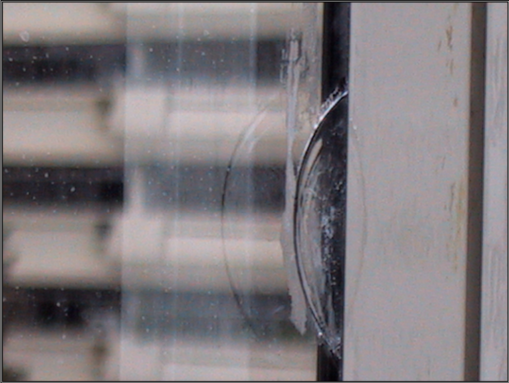
Figure 7: Edge spall
